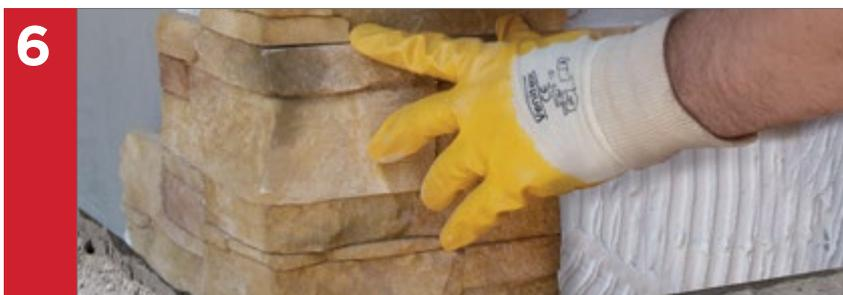
6 Wenn die Installation Ecken umfasst, beginnen Sie an der Ecke der Wand und setzen Sie die Installation entlang der flachen Elemente fort.
