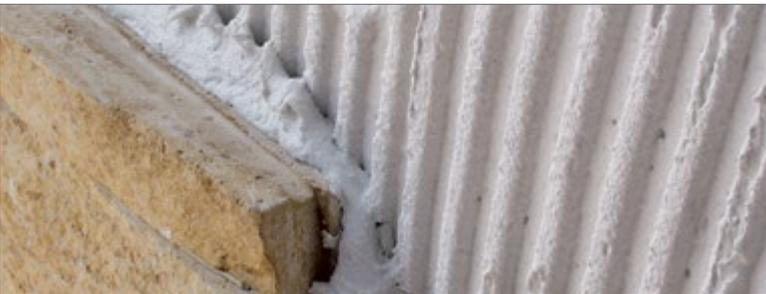
Platzieren Sie den Stein durch kräftigen Druck, um eine sehr gute Haftung des Mörtels auf der Rückseite des Steins zu gewährleisten.
