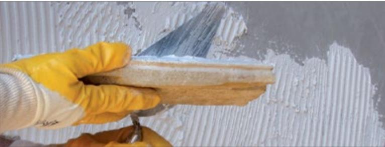
Tragen Sie Mörtel so weit wie möglich auf die Rückseite des Steins auf, sodass kein Spalt zwischen Stein und Oberfläche entsteht.
