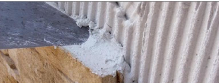
Füllen Sie den Umfangskanal des Steins mit dem Spachtel mit Mörtel. Entfernen Sie überschüssigen Mörtel mit einem Handtuch.
