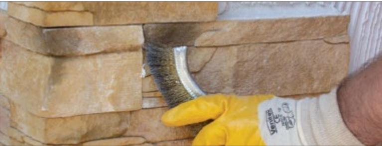
Reinigen Sie die Steinoberfläche vor dem Aushärten des Mörtels mit einer weichen Drahtbürste von Mörtelresten.
