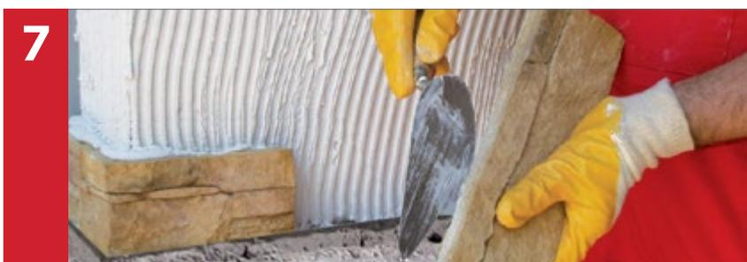
7 Reinigen Sie den Stein mit dem Spachtel oder einem ähnlichen Werkzeug rundherum von überlappendem Beton, um eine bessere Installation zu gewährleisten. Da die Rückseite des Steins trocken ist, befeuchten Sie ihn mit Wasser, um zu verhindern, dass der Mörtel Wasser aufnimmt.
