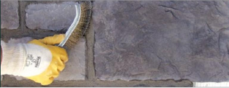
Wenn Mörtel vor dem Aushärten auf die Steinoberfläche gelangt (nach 1/2 oder 1 Stunde) bürsten Sie den Mörtel mit einer weichen Drahtbürste oder einem Hartplastik ab, verwenden Sie kein Metall.
