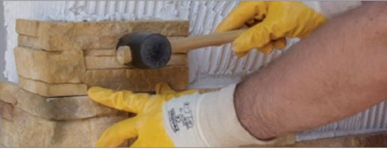
Verwenden Sie beim Verlegen von Steinen einen Gummihammer, um den Stein nicht zu beschädigen.
