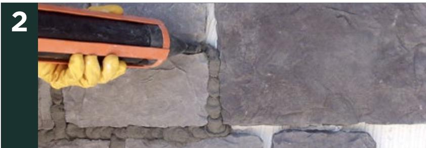
Für die Verlegung verwenden Sie einen Spritzbeutel oder eine Fugenpistole. In beiden Fällen schneiden Sie das Ende effektiv ab, bis die gewünschte Breite für die Fuge erreicht ist.
