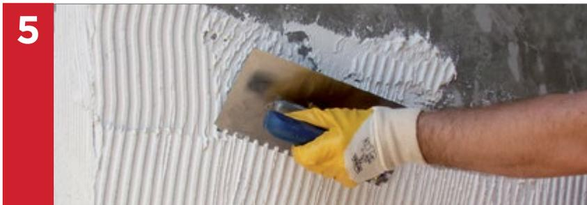
5 Tragen Sie so viel Mörtel auf die Verlegefläche auf, dass dieser beim Verlegen des Steins nicht austrocknet.
